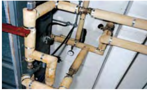
Asbestos pipe lagging
